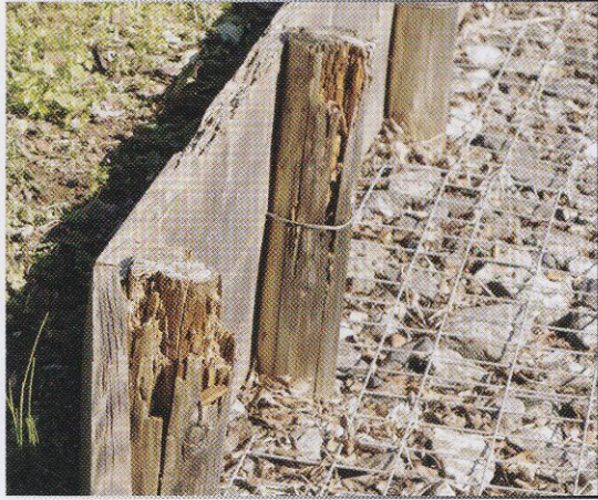
同じ杉の丸太でも桜の大木の下丸太は日陰になるため腐っている
